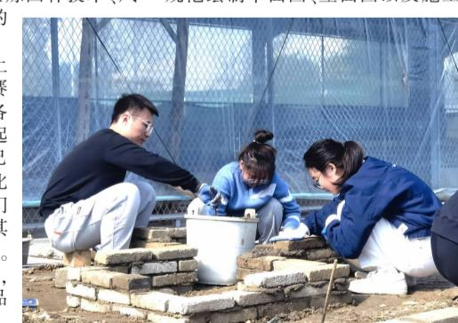
详图,并将设计方案按图施工落实到规定场地内。从施工准备、放线测量、搅拌水泥,到逐层砌筑、复测调整,耗时较长,体能消耗大。
